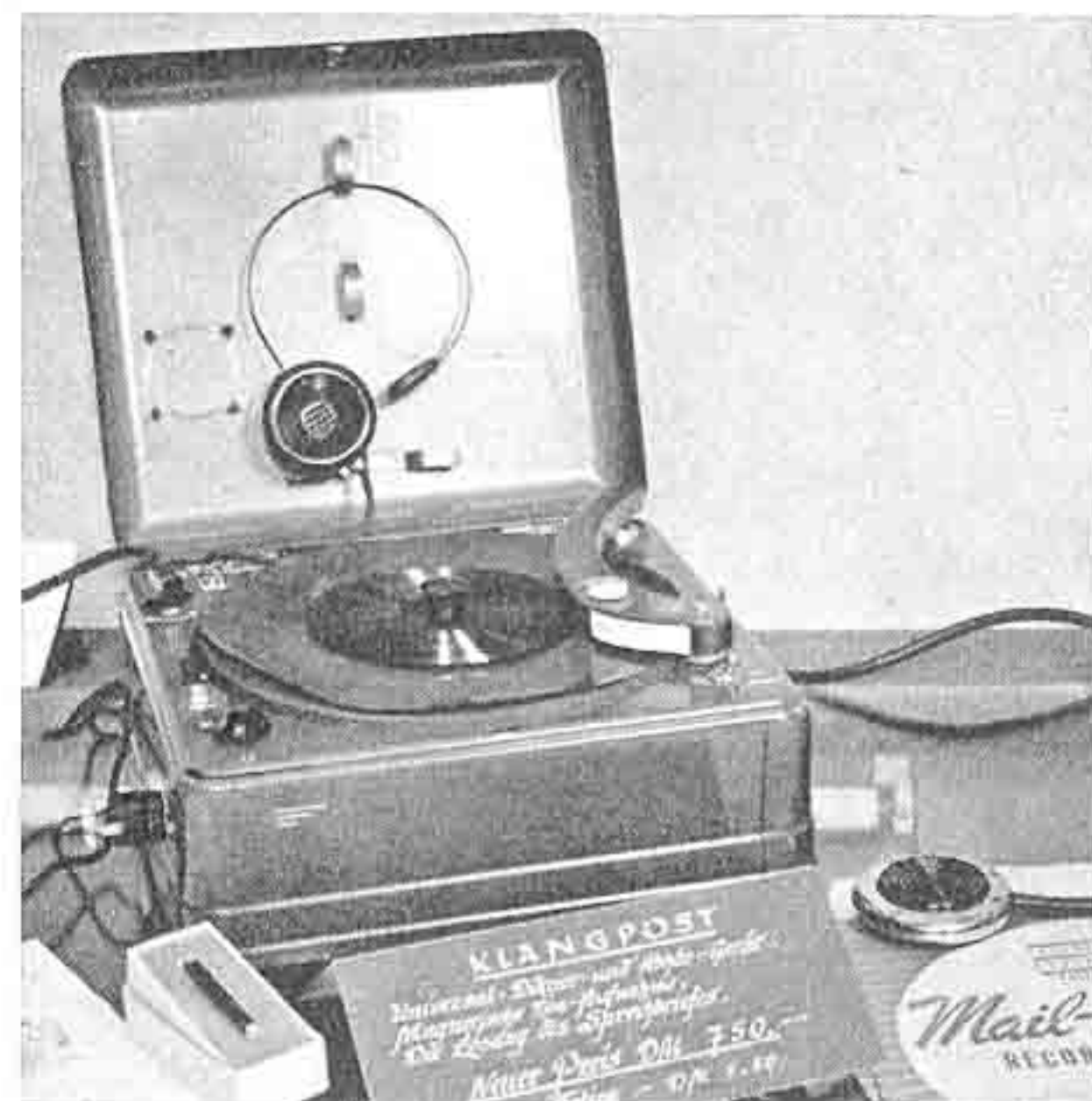
Die AEG baut ihr Magnetofon AW 1 jetzt in eine Truhe ein und hat außerdem einen Ortsempfänger bester Wiedergabe für Schallaufnahmen vorgesehen
